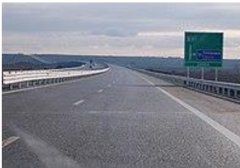
Autostrada A1 în apropiere de Timișoara
